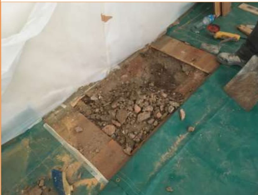
Foto 8. Vista de l'extracció del paviment UE 20 i nivell UE 24.
