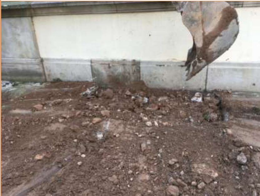
Foto 20. Vista de l'estat final de la cala 4 després del seu cobriment.
