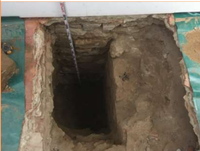
Foto 6. Vista final de la cala núm. 1, murs UE 5 i UE 7.
