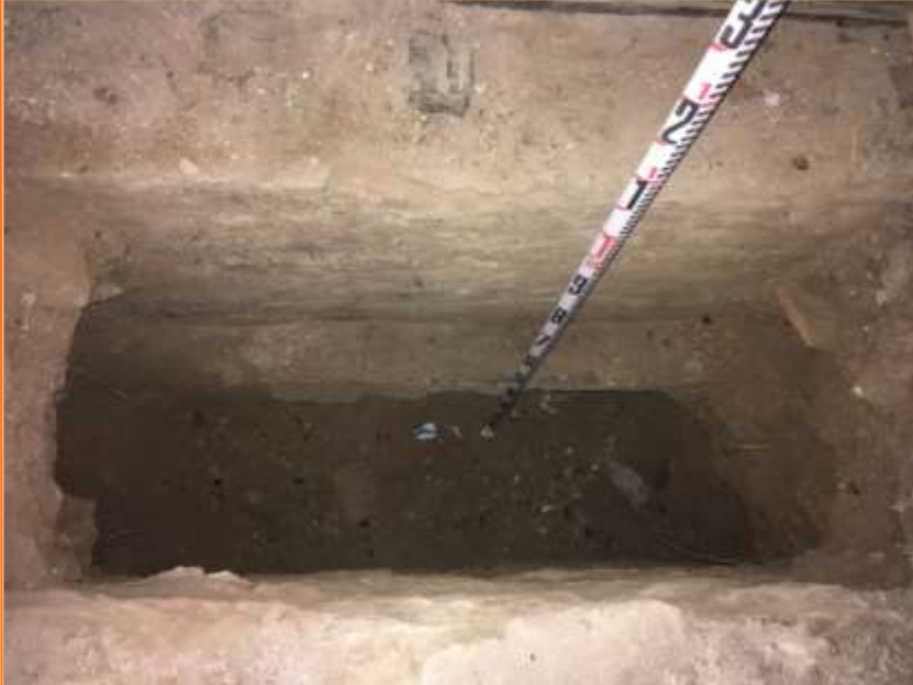
Foto 9. Vista del mur de fonamentació UE 21 i de la claveguera UE 23.
