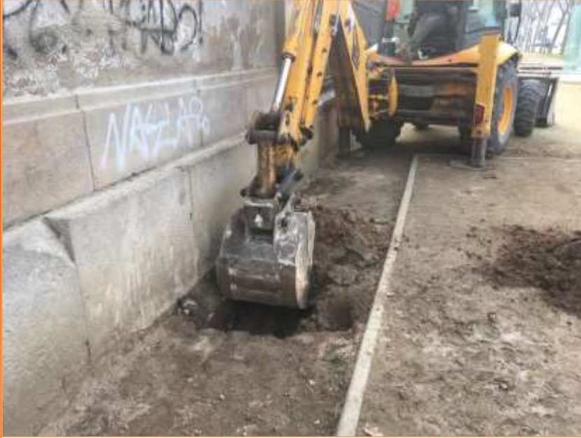
Foto 21. Vista de l'inici dels treballs de l'excavació de la cala número 5.
