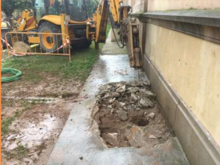
Foto 17. Vista dels treballs d'ampliació de la cala núm. 4, extracció de la UE 40.
