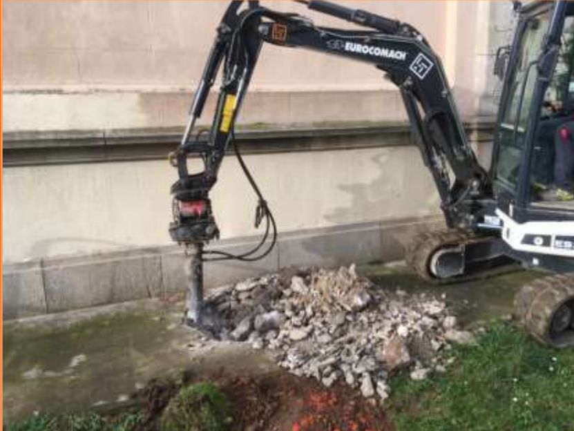
Foto 15. Vista dels treballs inicial de l'extracció del paviment UE 40.
