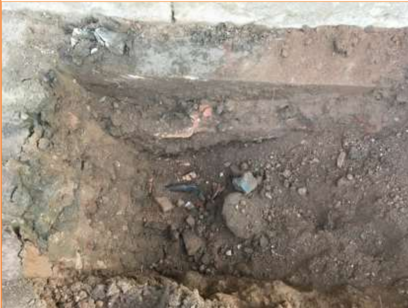
Foto 22. Vista del servei que va aparèixer i que va provocar l'abandonament de la cala núm. 5.
