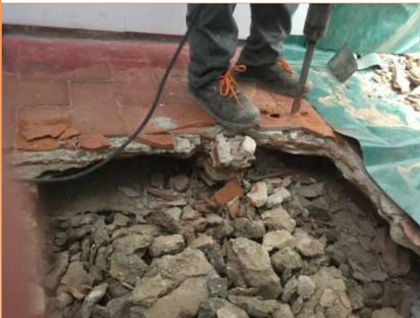
Foto 2. Vista dels treballs d'extracció del paviment UE 1.
