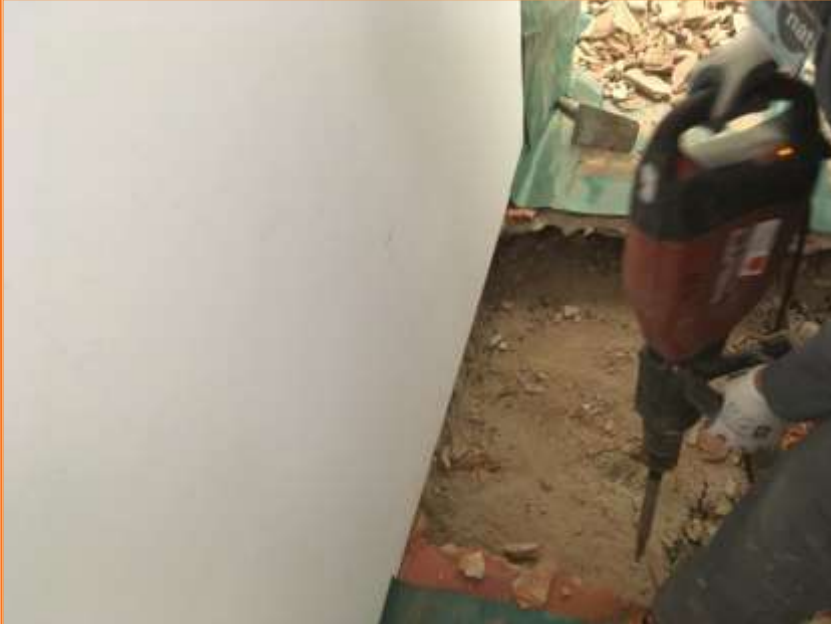
Foto 3. Vista dels treballs d'extracció del paviment UE 2.
